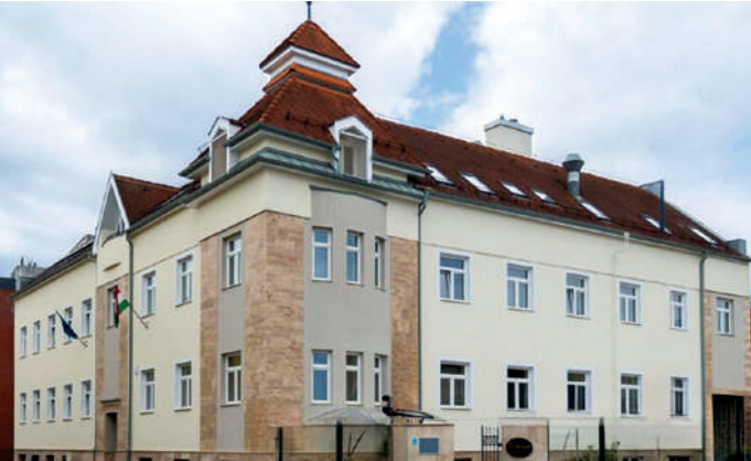
„Sárga ház” felújítása Renovation of „Yellow House” Renovierung des „Gelben Hauses” Őriszentpéter
